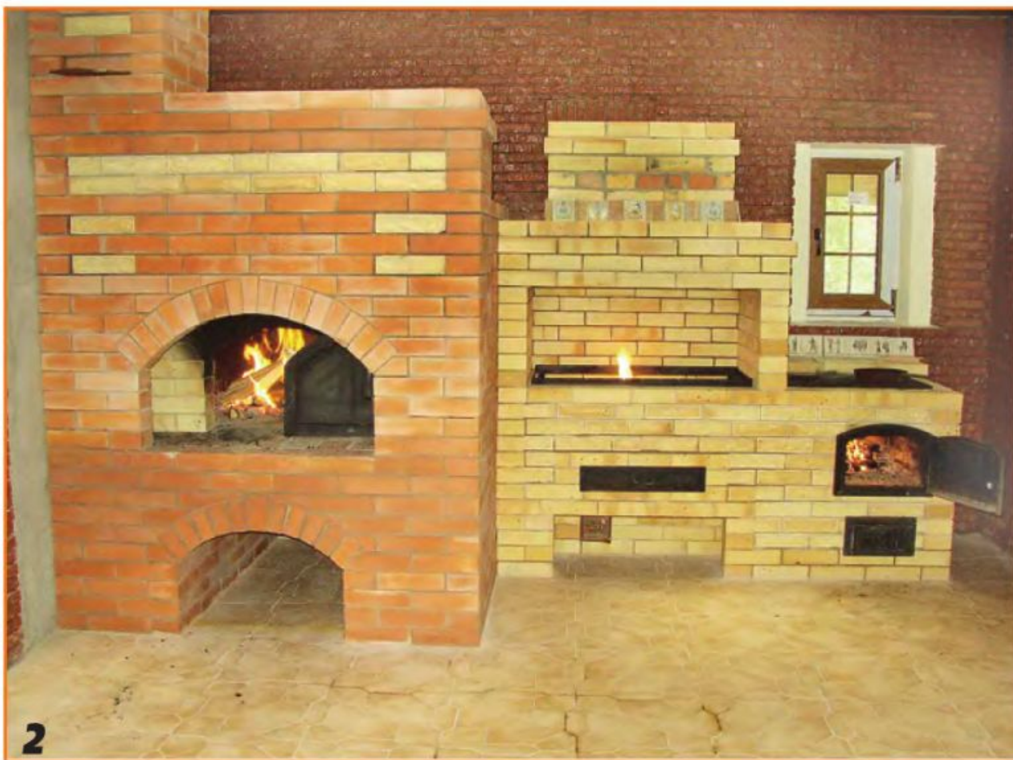
Так выглядит кухонный печной комплекс, состоящий из трёх очагов.
