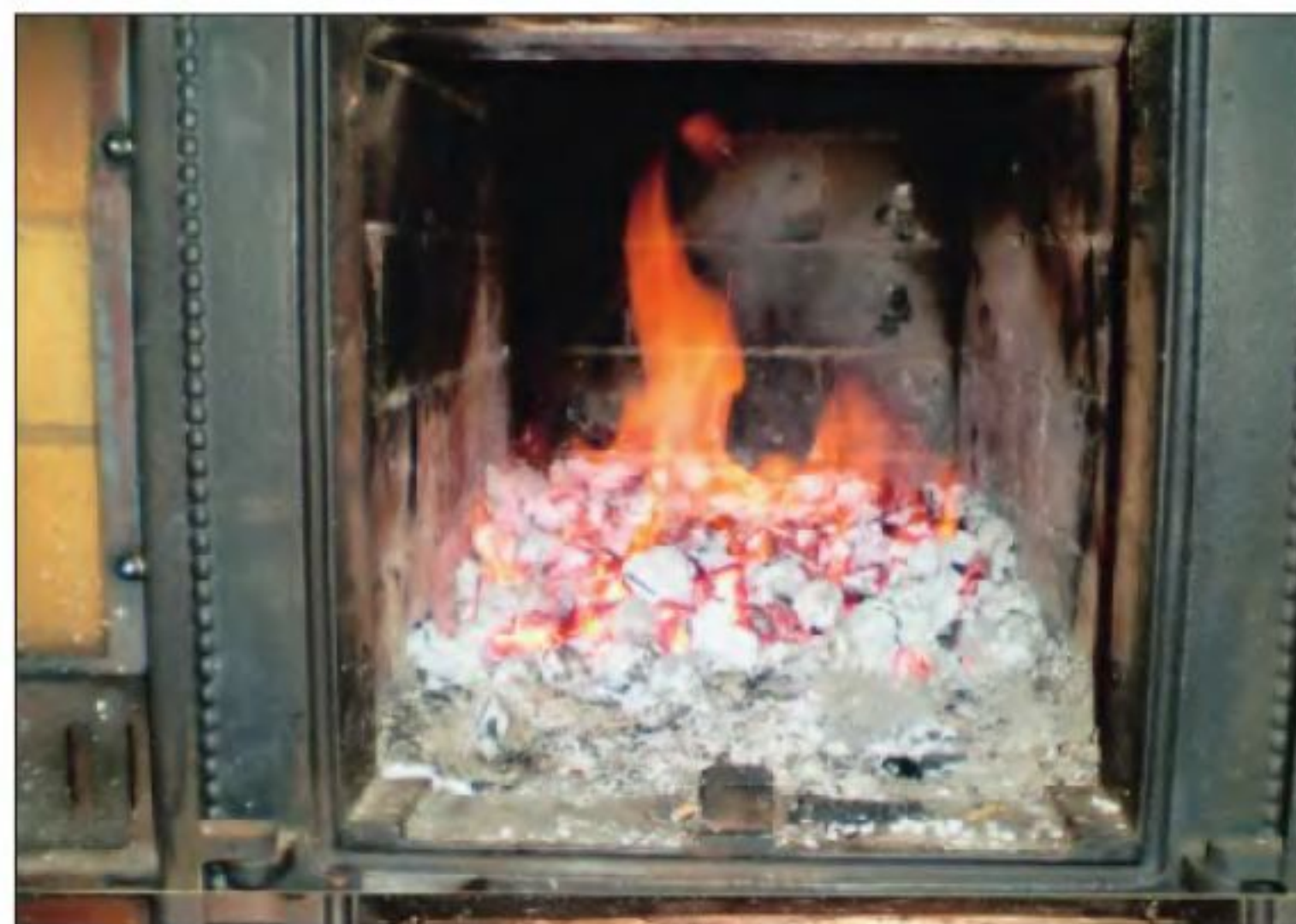
А если открыть поддувало, добавив воздух в зону горения, появятся языки пламени — это сгорает накопившийся угарный газ.
