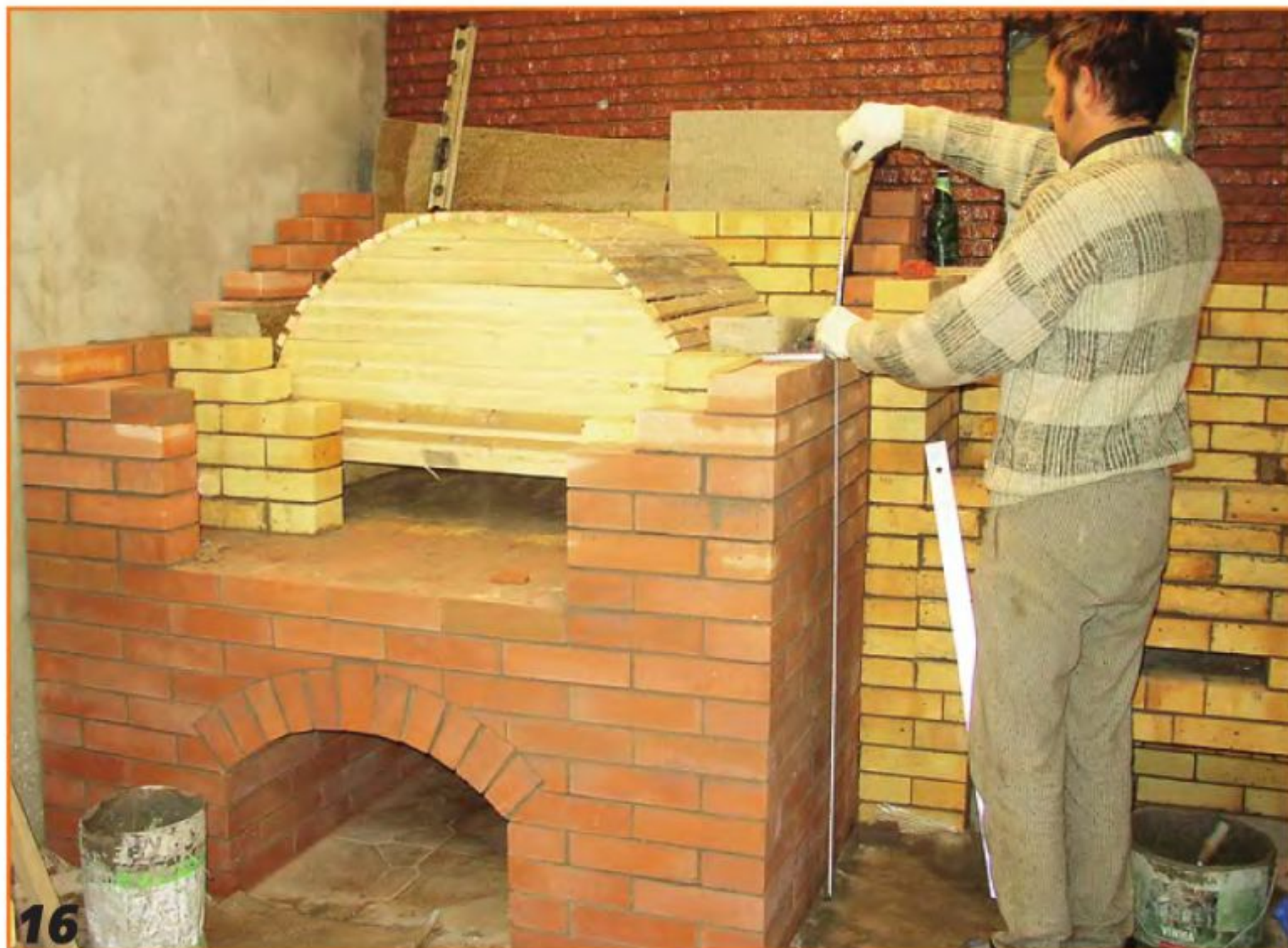
Ещё раз проверили высоту будущей печи.
