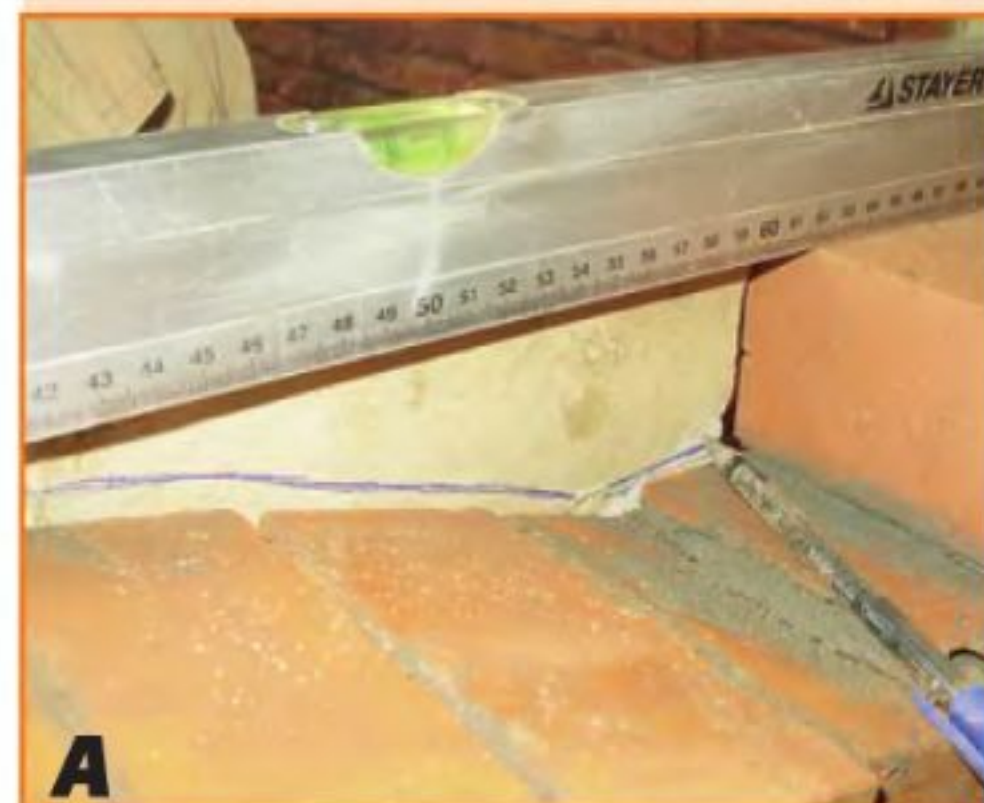
Приложив лист картона к вертикальной поверхности, обрисовали на нём очертания будущего кирпича.
