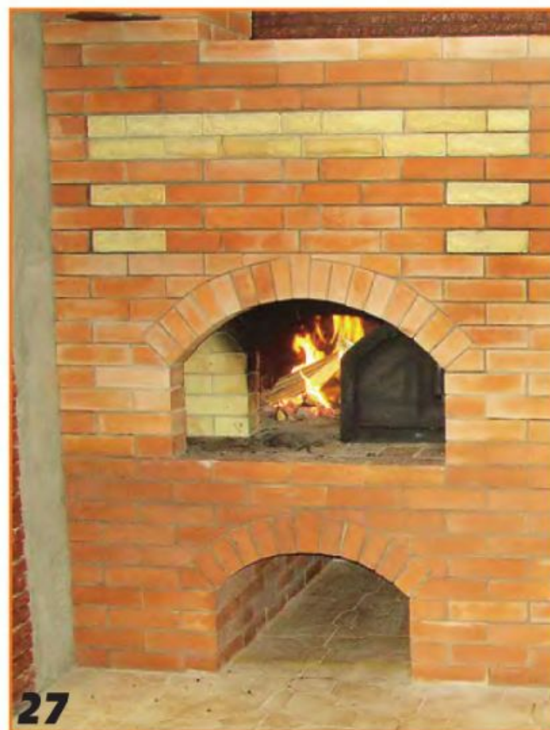
27 Режим горения в топливнике русской печи регулируется прикрытием металлической заслонки.
