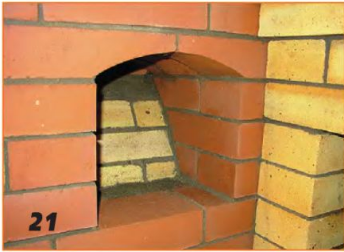
А это — печурка русской печи. Она же — ступенька для залезания на лежанку русской печи.
