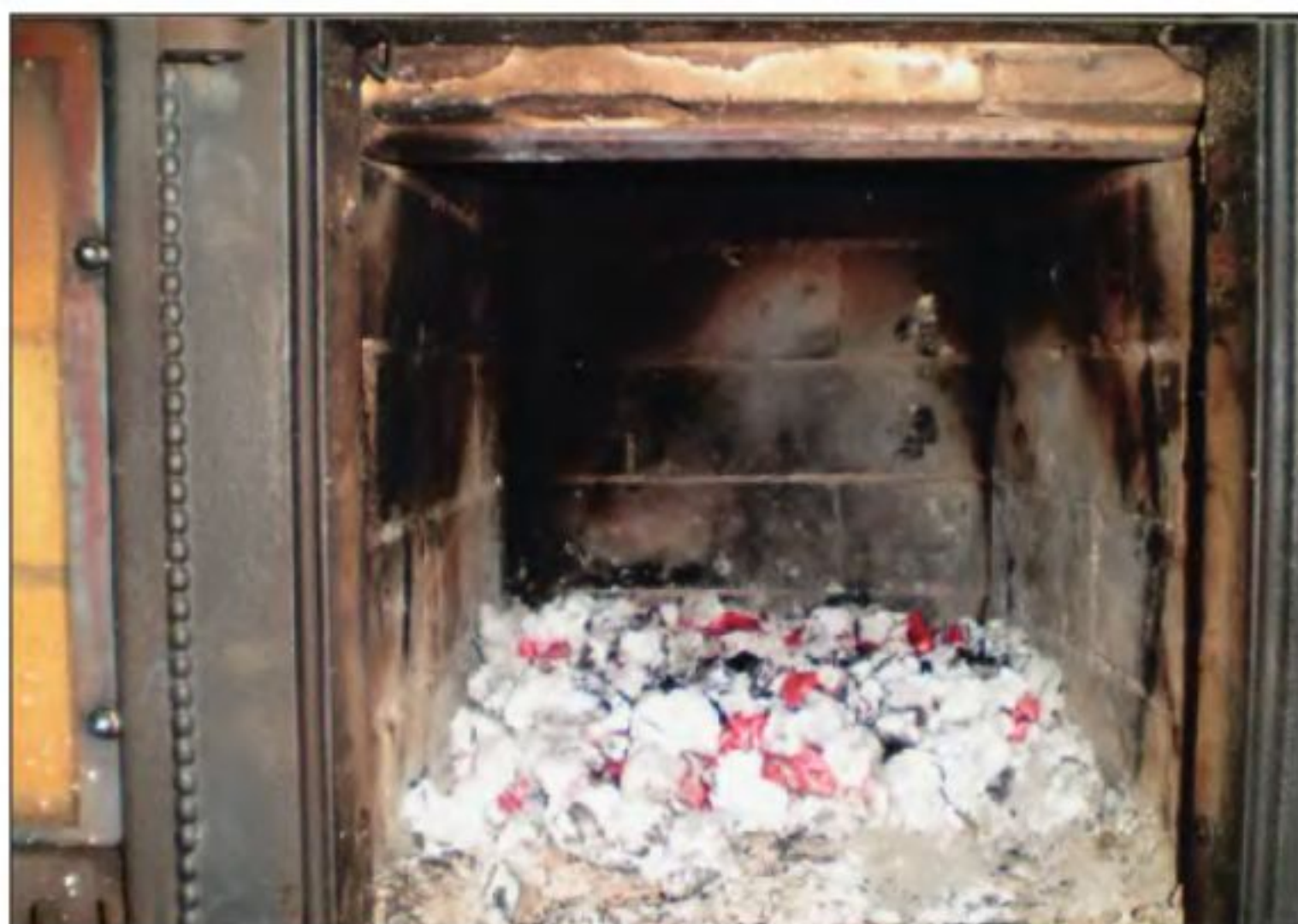
Открыв топку при закрытой печной заслонке, можно наблюдать «мирную» картину тлеющих угольков.
