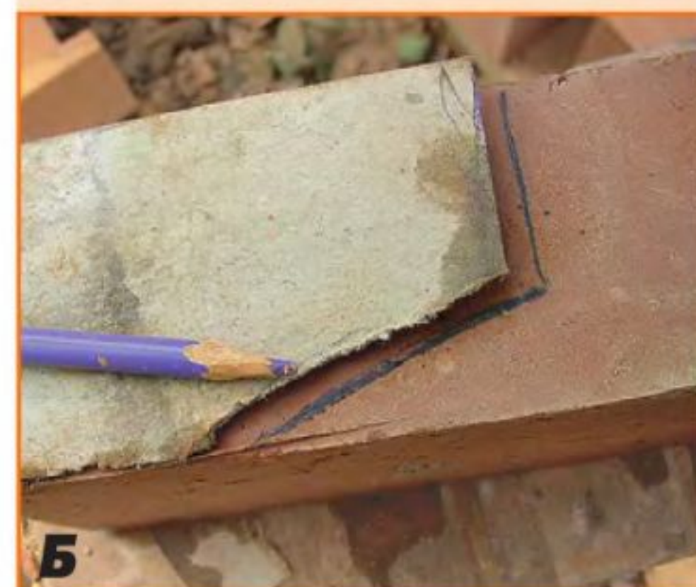
Таким образом получили шаблон для изготовления нестандартного кирпича. Перенесли контуры на кирпич.
