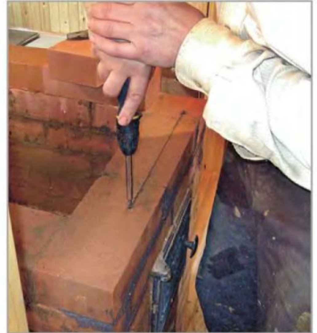
Ряды нижнего яруса стянули для прочности стальной проволокой.
