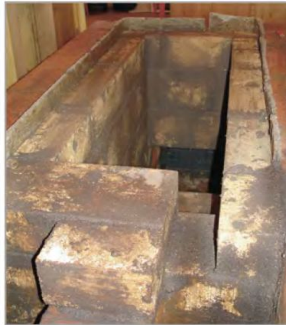
Небольшой растопочный ход обеспечит лёгкую растопку холодной печи.
