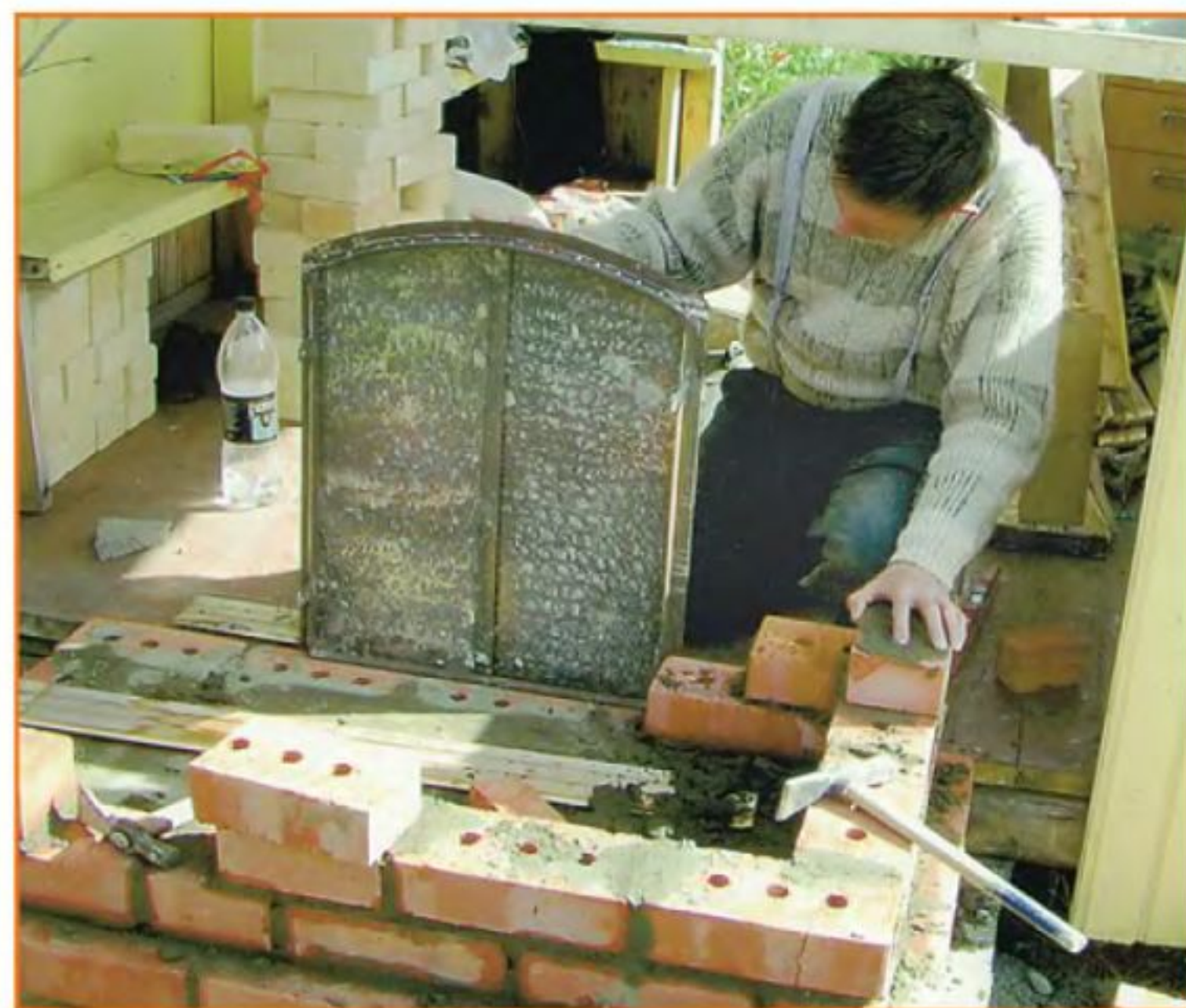
Нишу для хранения дров и пакета с древесным углём не оставили открытой — во время кладки установили двухстворчатую стальную дверку.
