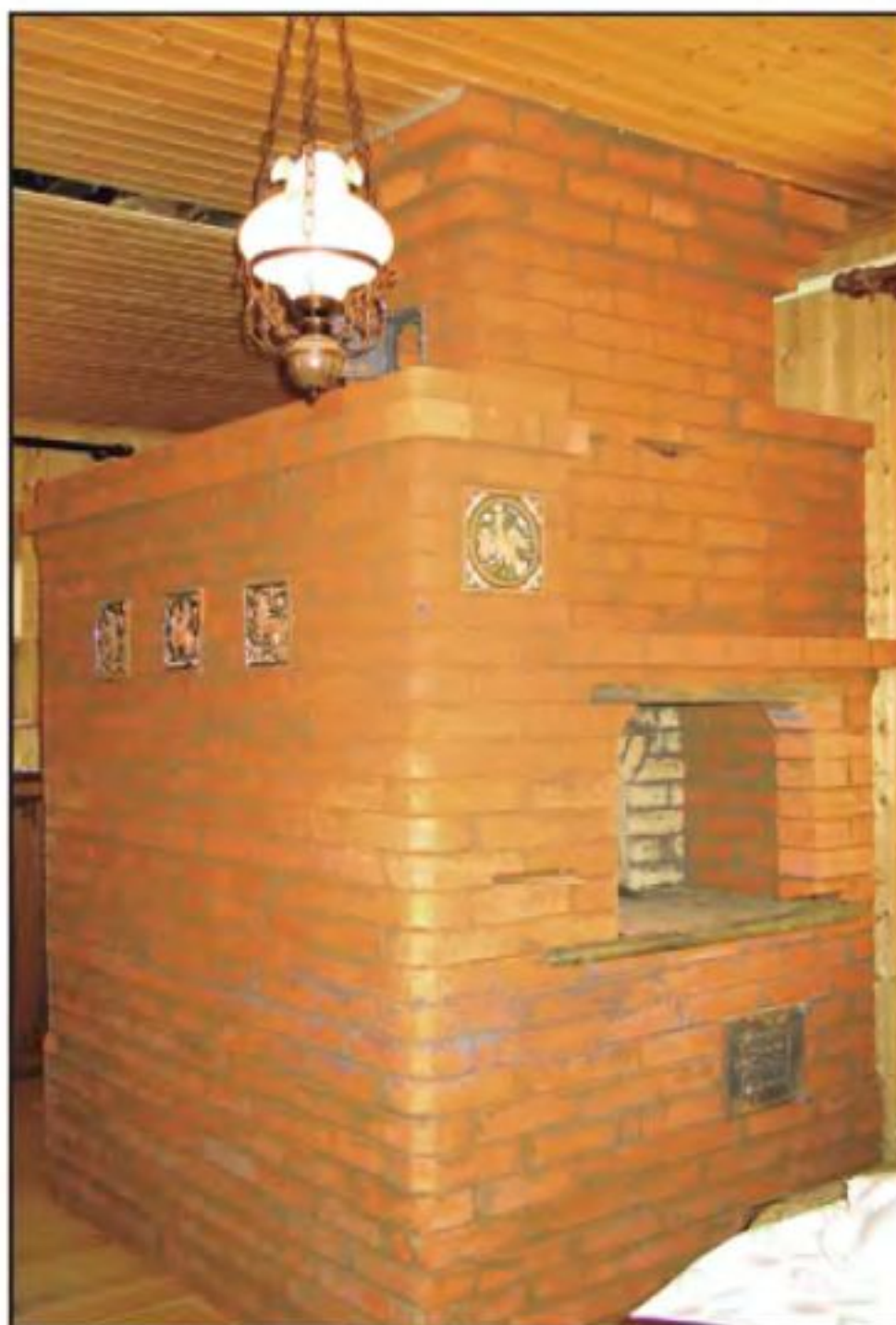
Печь готова к оштукатуриванию.
