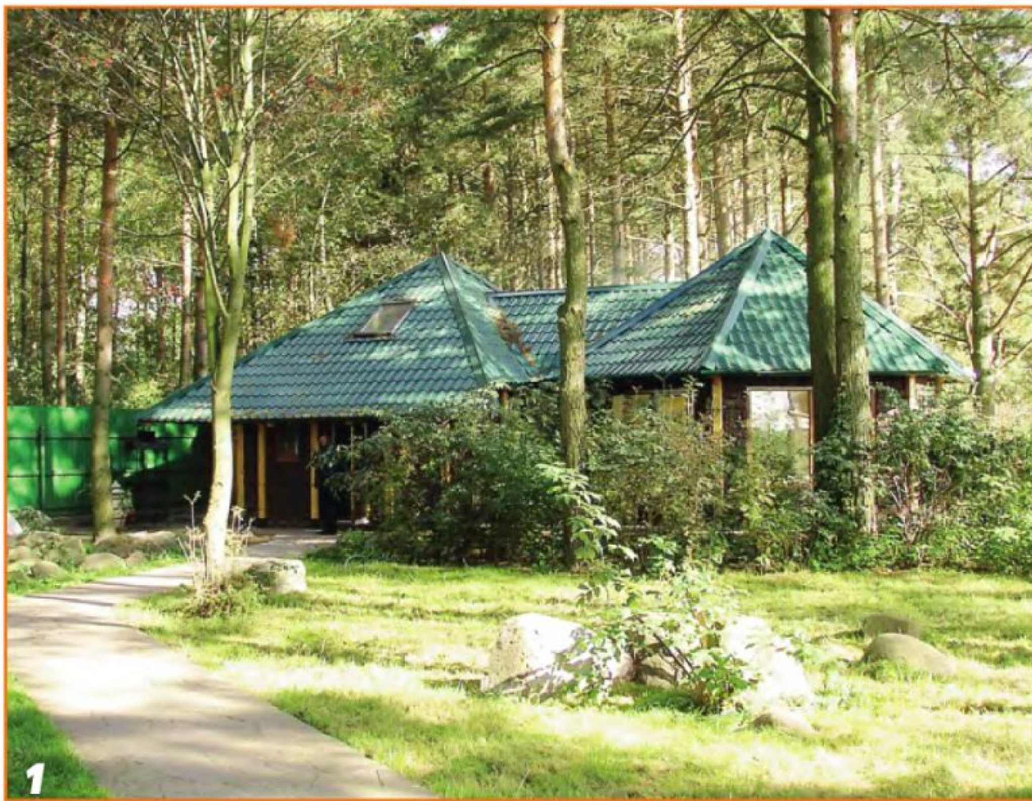
Летняя кухня, построенная из шлакоблоков, находится в тени деревьев. В тёплое время года температура внутри помещения всегда ниже температуры воздуха снаружи, что является неблагоприятным фактором для естественной тяги печей.
