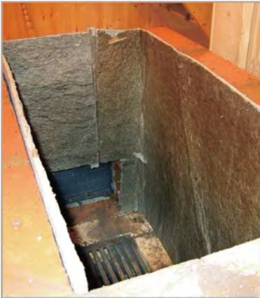
Футеровка топки отделена от наружной кладки слоем базальтина.
