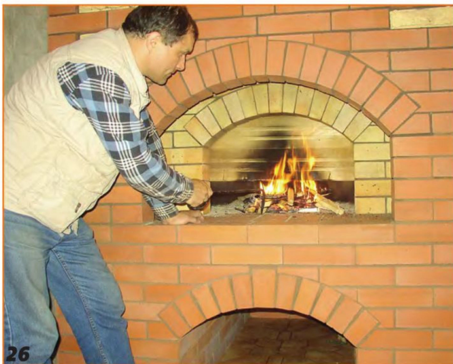
26 Последний штрих: Валерий выжигает опалубку в русской печи.
