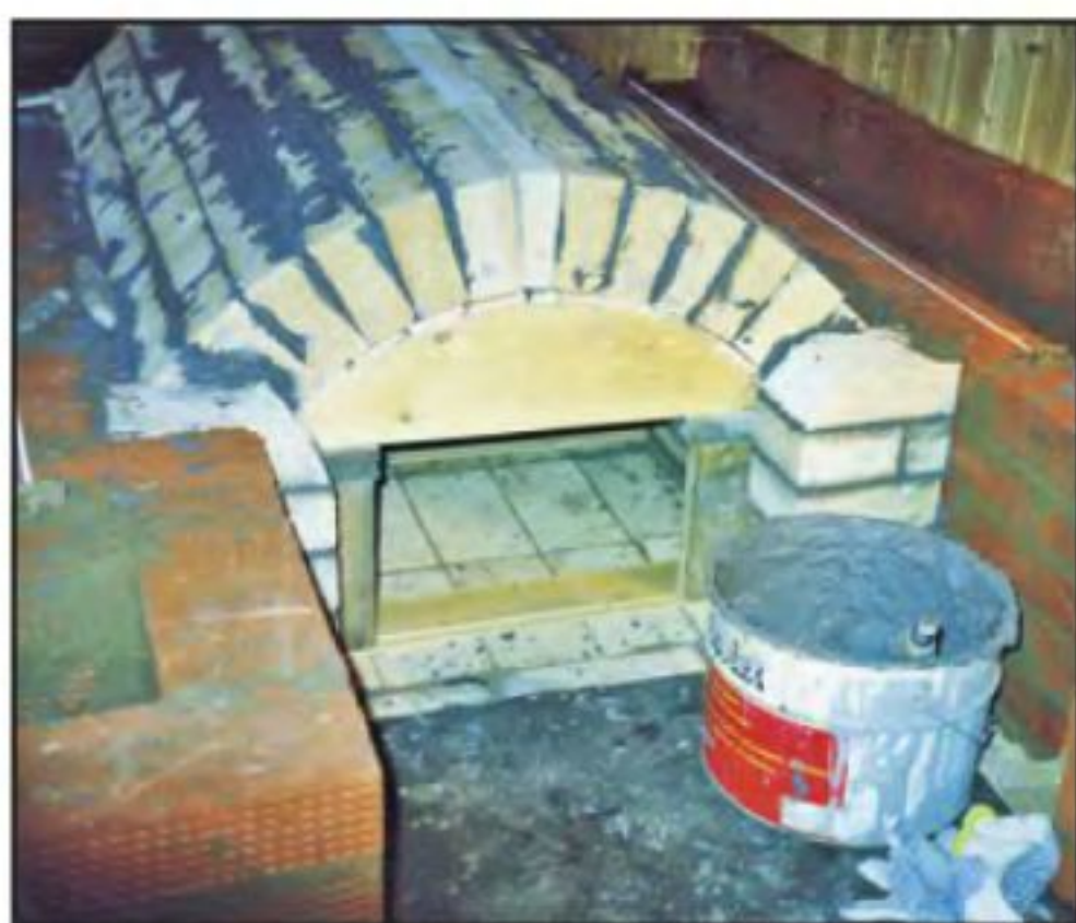
Свод топки выложен клиновидными шамотными кирпичами.
