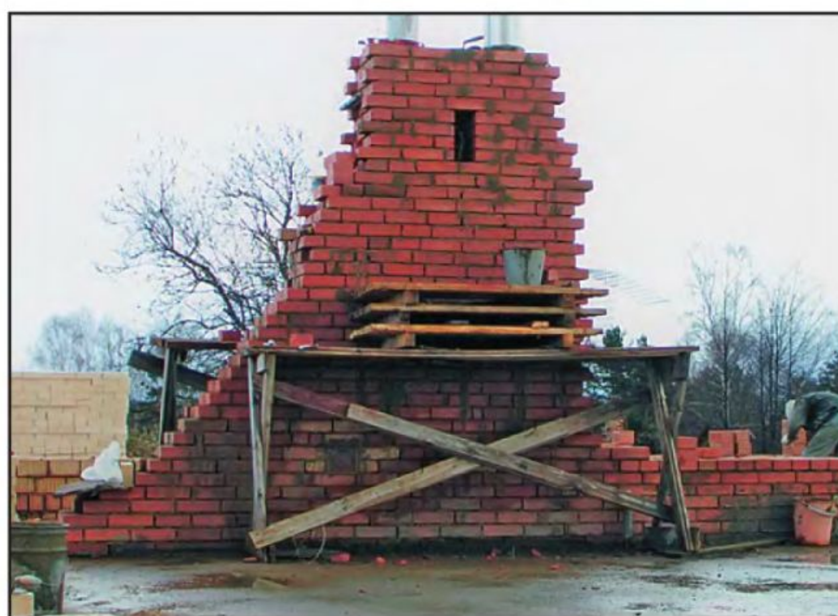
Кладка и трубы внутри неё выведены на отметку 3,5 м. Между двумя дымовыми трубами расположен вентиляционный канал.
