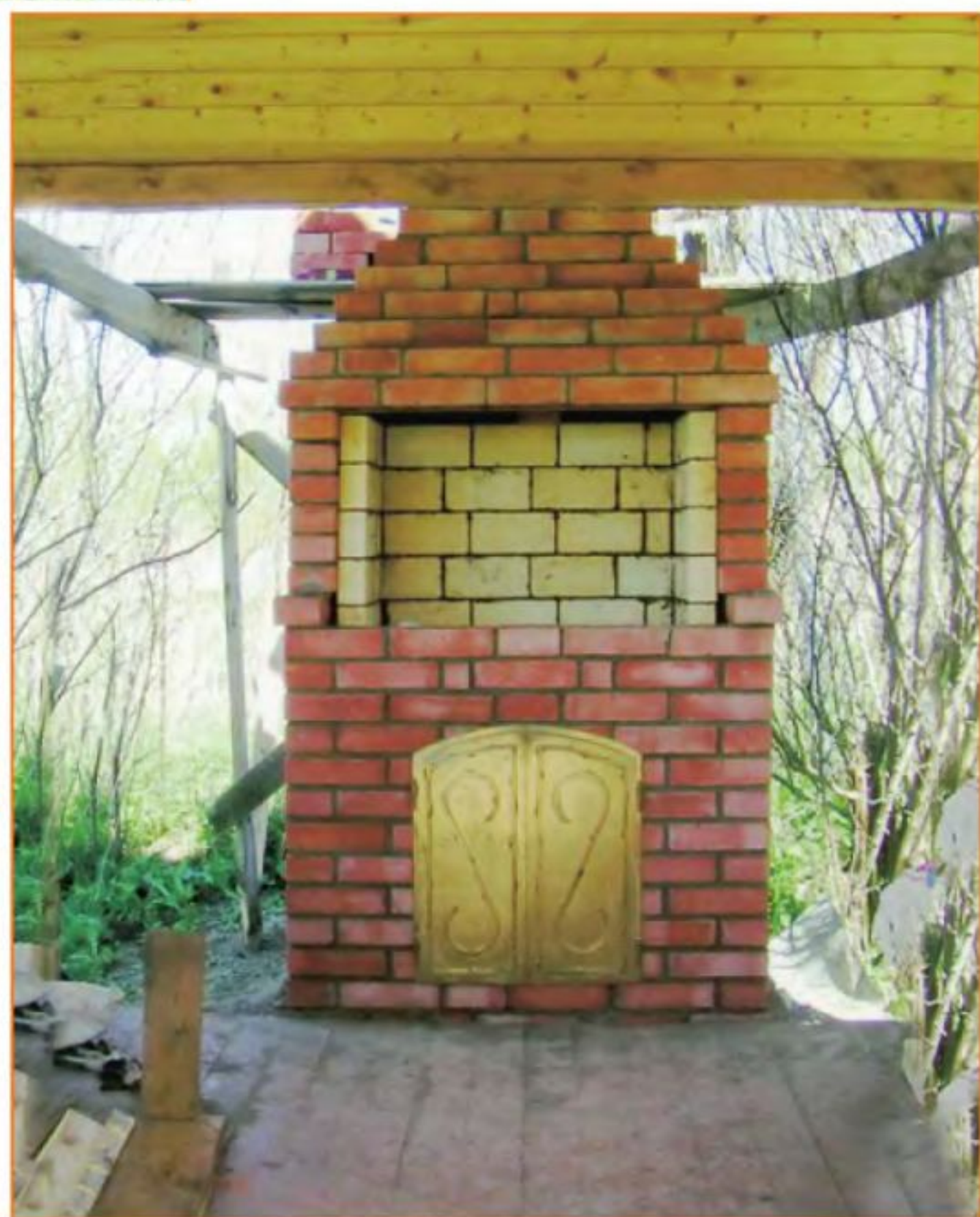
Всё готово для опробывания камина. В нашем уличном камине нет металлического мангала. Уголь раскладывается на колосниках. А для регулирования горения и сбора золы в боковой стене укрепили поддувальную дверку.
