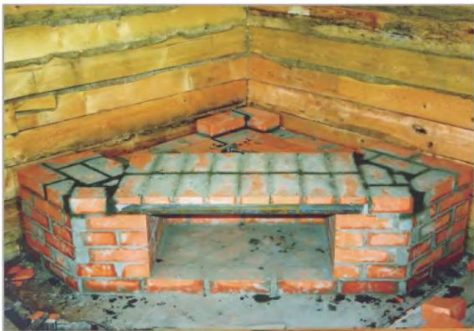
Дровница перекрыта по стальному уголку 45x50 мм.
