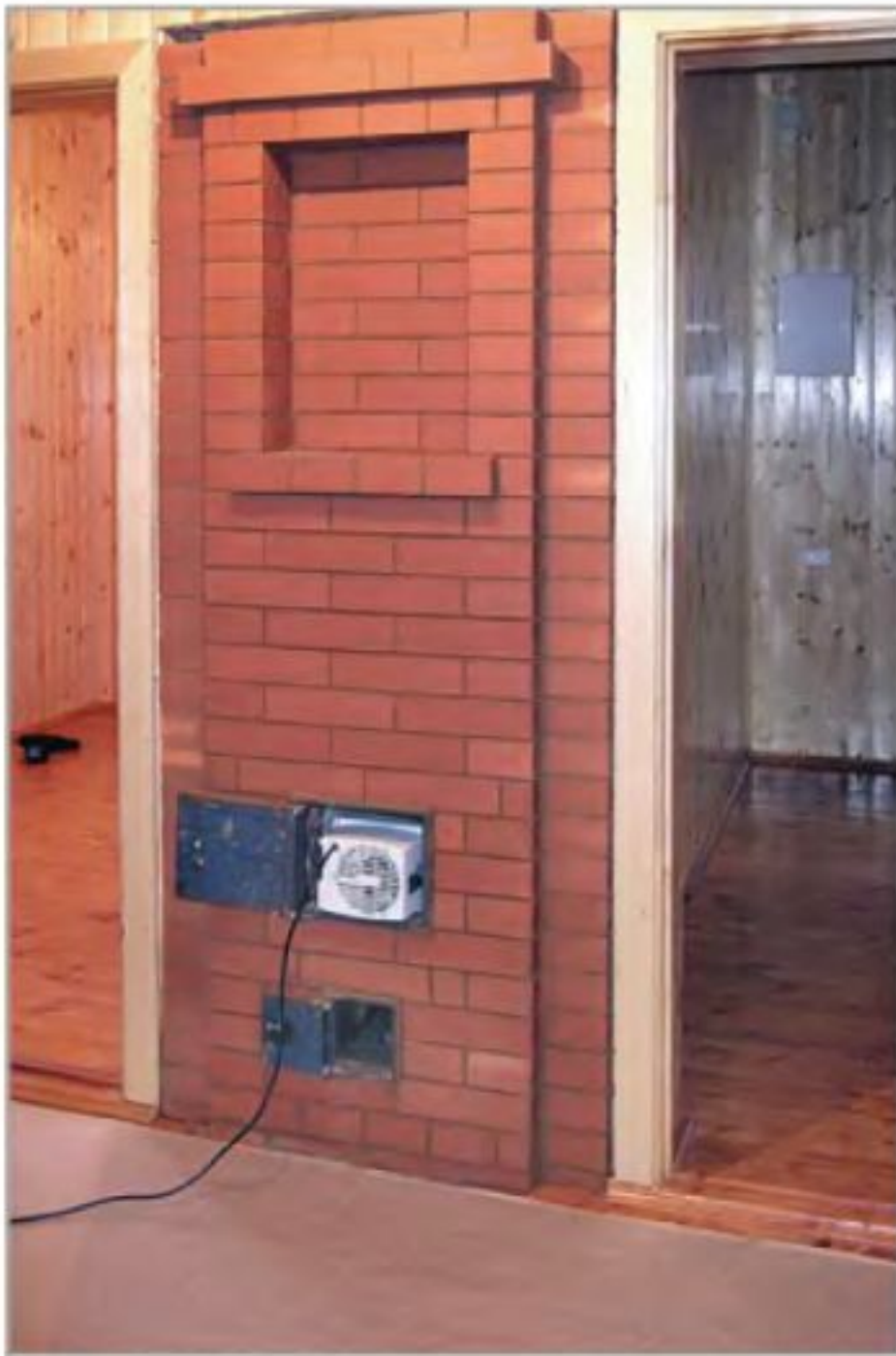
Для интенсивной сушки печи хорошо подошёл тепловентилятор.
