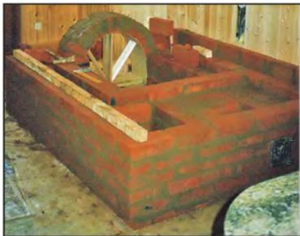
На заднем плане — арка подпечья.
