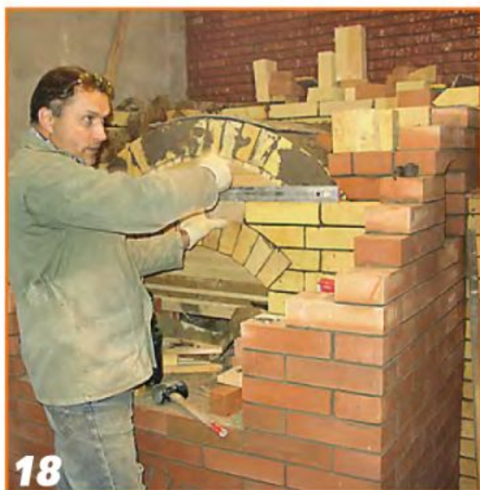
То кружало, которое использовали для кладки арки подпечья, применили и при кладке хайла топливника русской печи.
