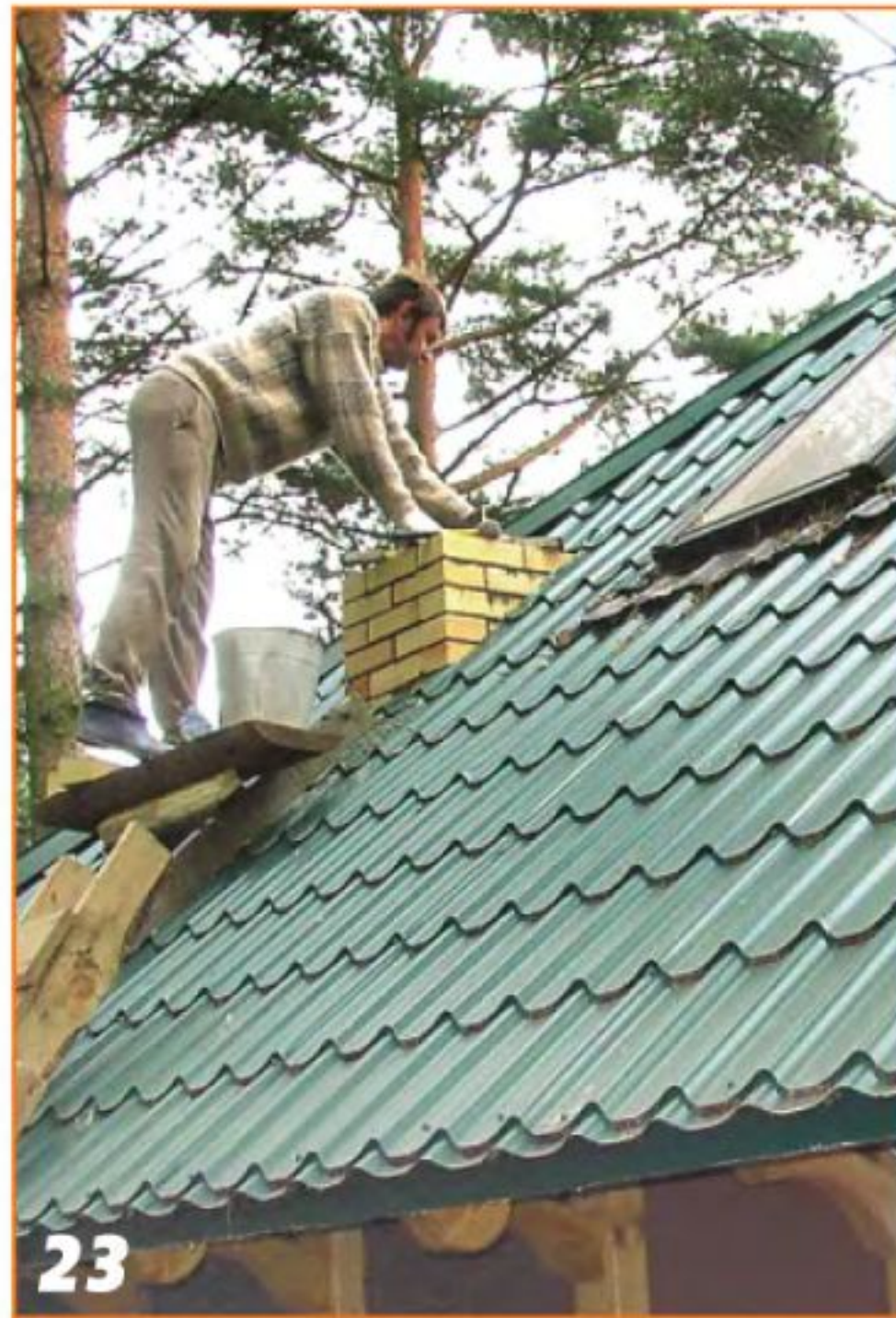
Кладку уличной части трубы вели уже на цементном растворе.
