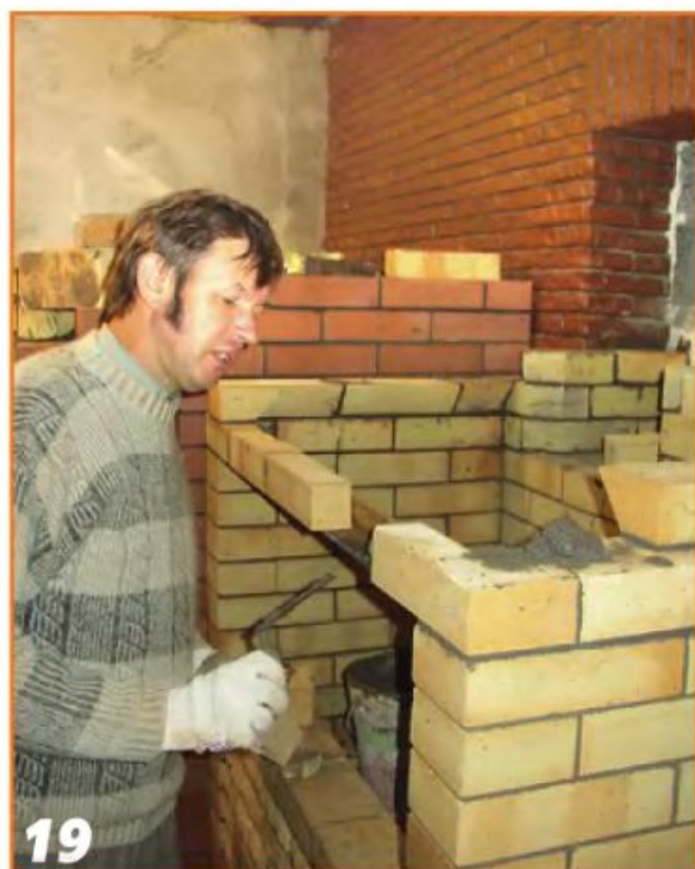
Перекрытие гриля сделали при помощи металлических уголков. А дымосборник сформировали, как у камина.
