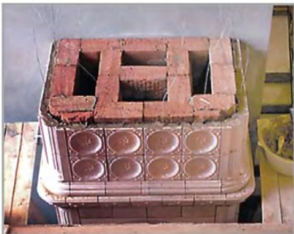
Этапы монтажа печи.
