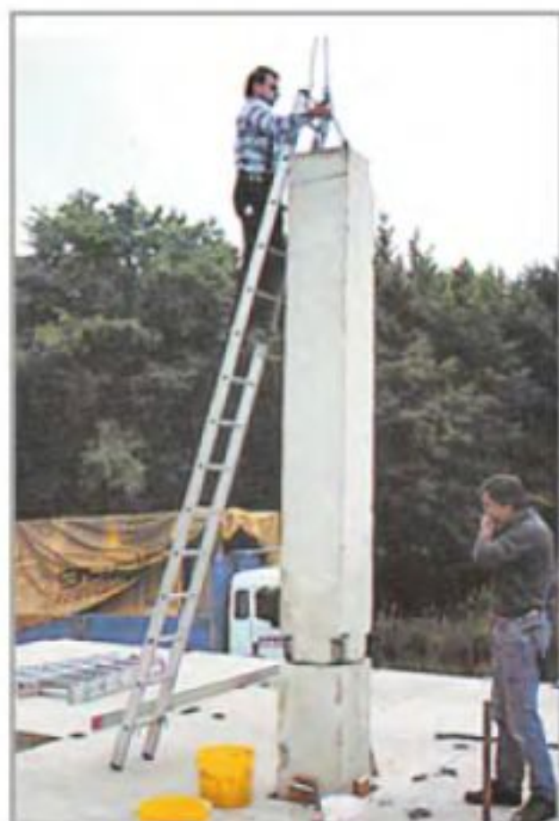
Сборные дымовые трубы двухэтажного дома состоят из трёх секций...
