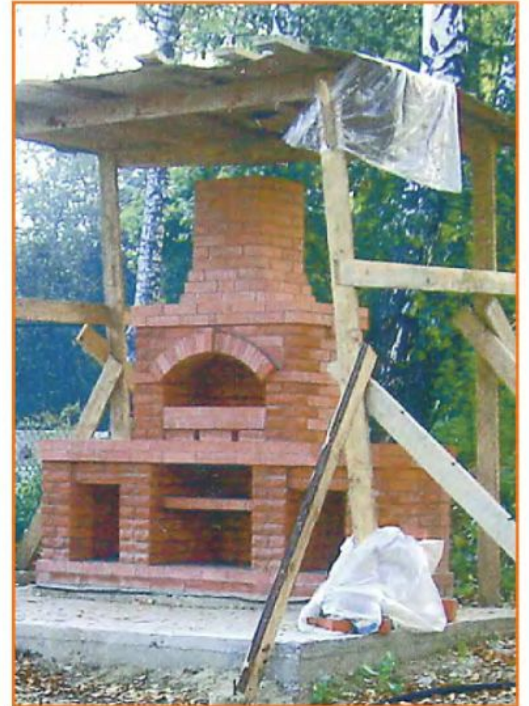
Прототипом для описываемых в этой статье уличных очагов послужил камин, который был сложен в одном из подмосковных дачных посёлков. (см. рис. внизу). Перекрытие портала камина сделано в виде свода-арки. Топку можно прикрывать заслонкой, как в русской печи. Воздух для горения топлива поступает через два поддувальных канала и колосниковую решётку.
