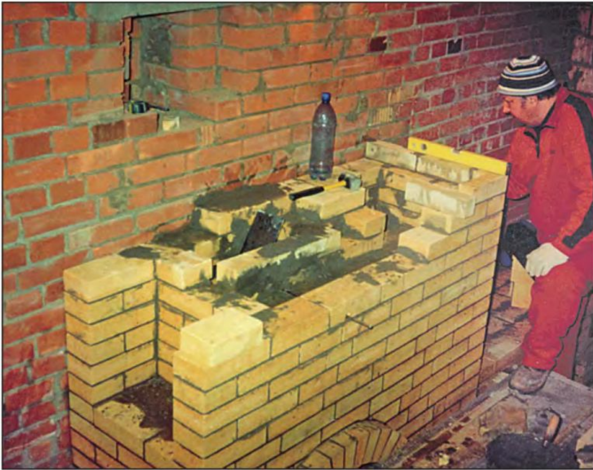
В левой боковой стенке камина устроена ниша, напоминающая печурку русской печи.
