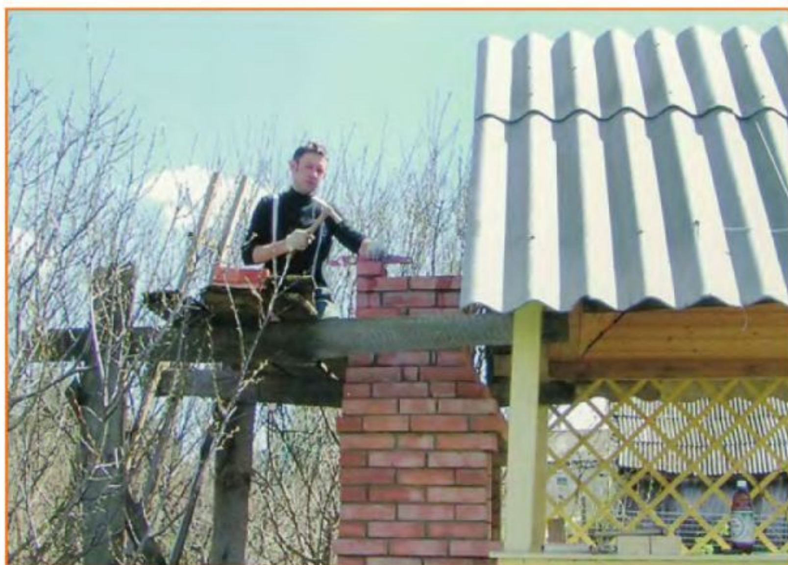
Так как этот очаг предполагалось использовать и как камин, то во избежание дымления из топливника трубу выкладывали в шесть кирпичей с внутренним сечением 260x260 мм.
