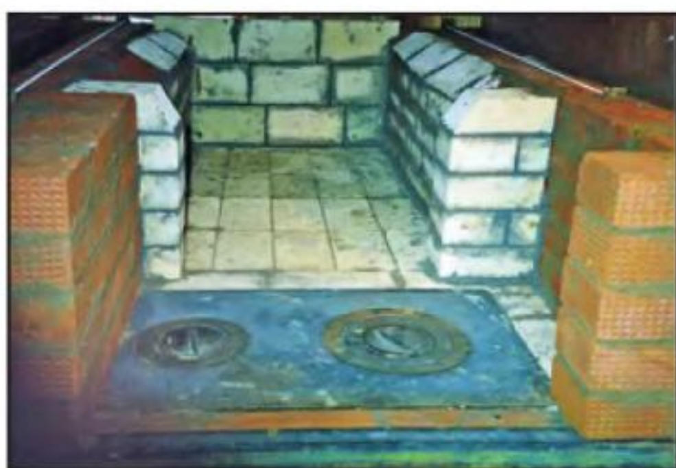
Подготовленные пяточные кирпичи — опора под свод.
