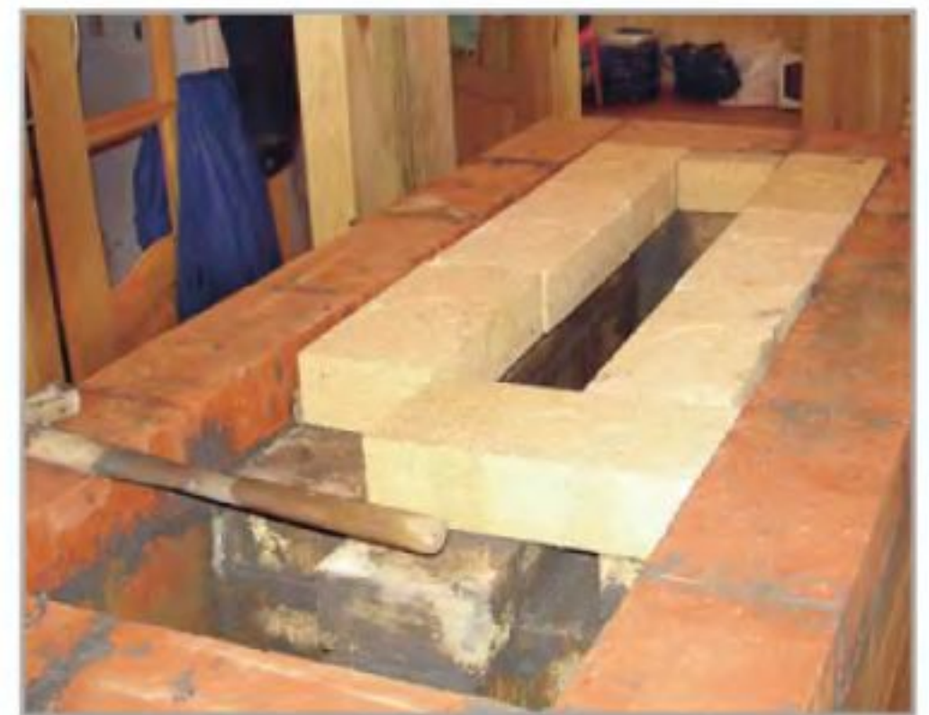
Топочная камера перекрывалась шамотным кирпичом в два приёма.
