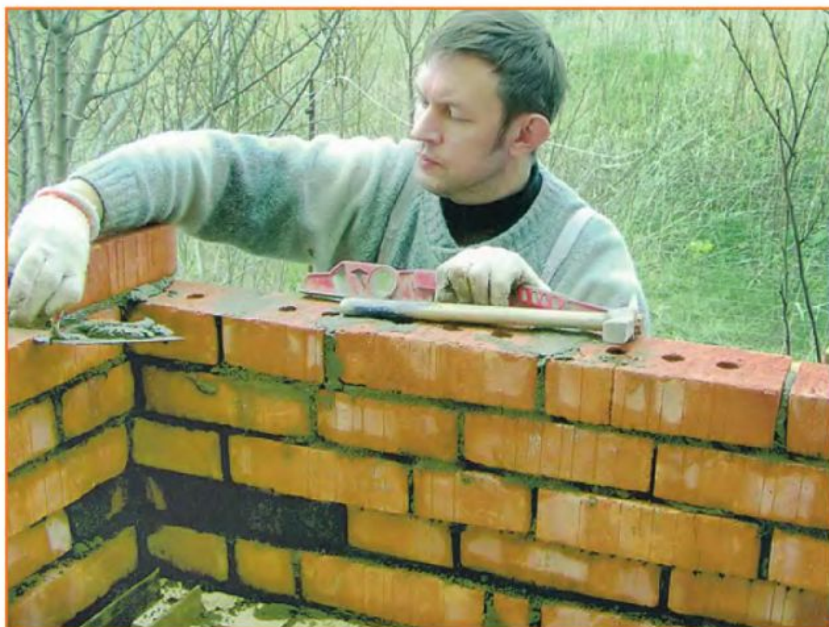
В основном использовали красный кирпич с тремя отверстиями. Для кладки применяли цементно-песчаный раствор.
