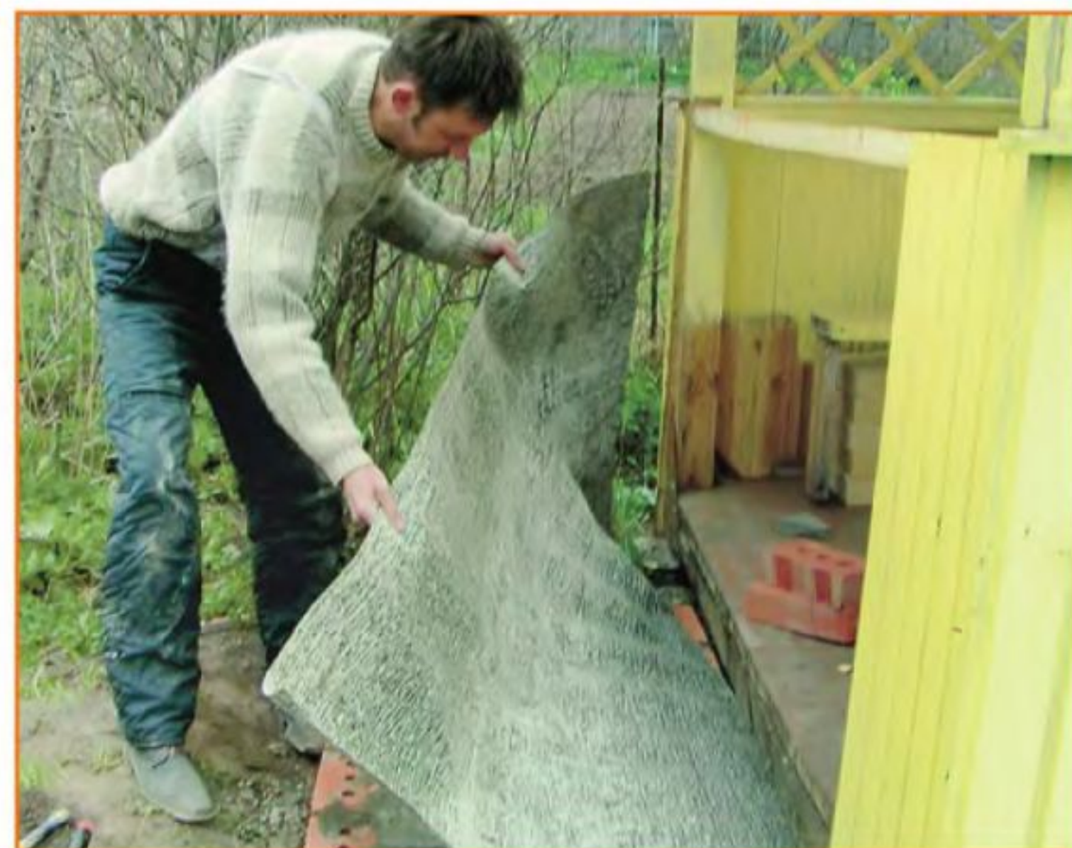
Гидроизоляцию проложили не на уровне грунта, а чуть выше, так как беседка стояла на столбчатом фундаменте.
