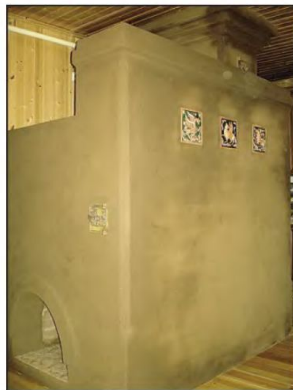
Тепловой щиток со стороны подпечья.
