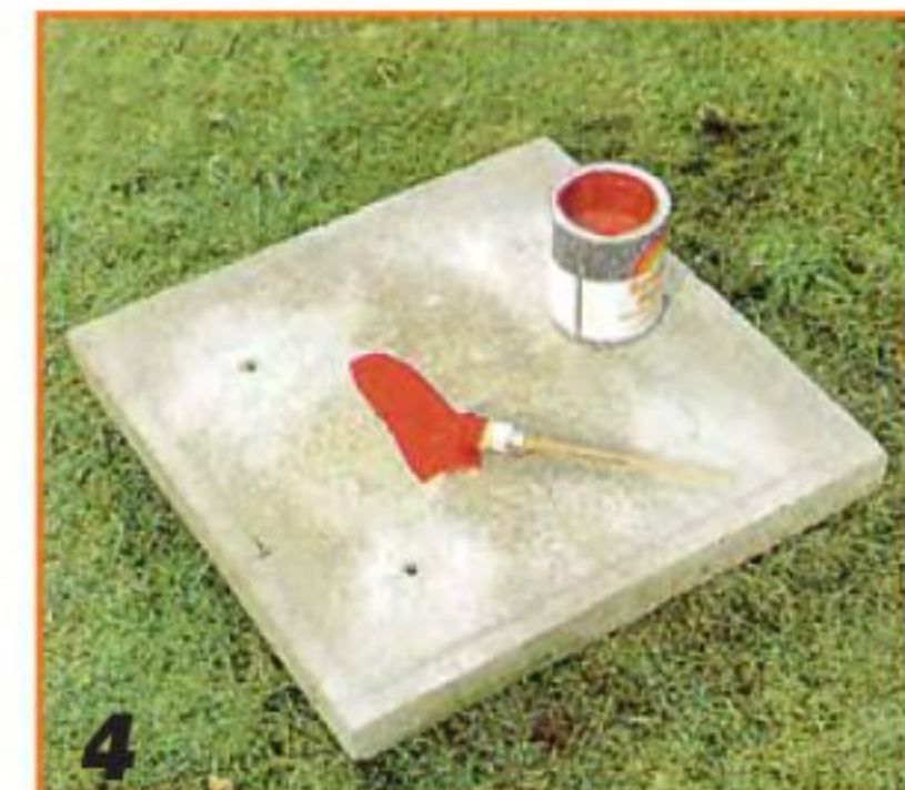
4 Плиты с отверстиями перед сборкой красят.
