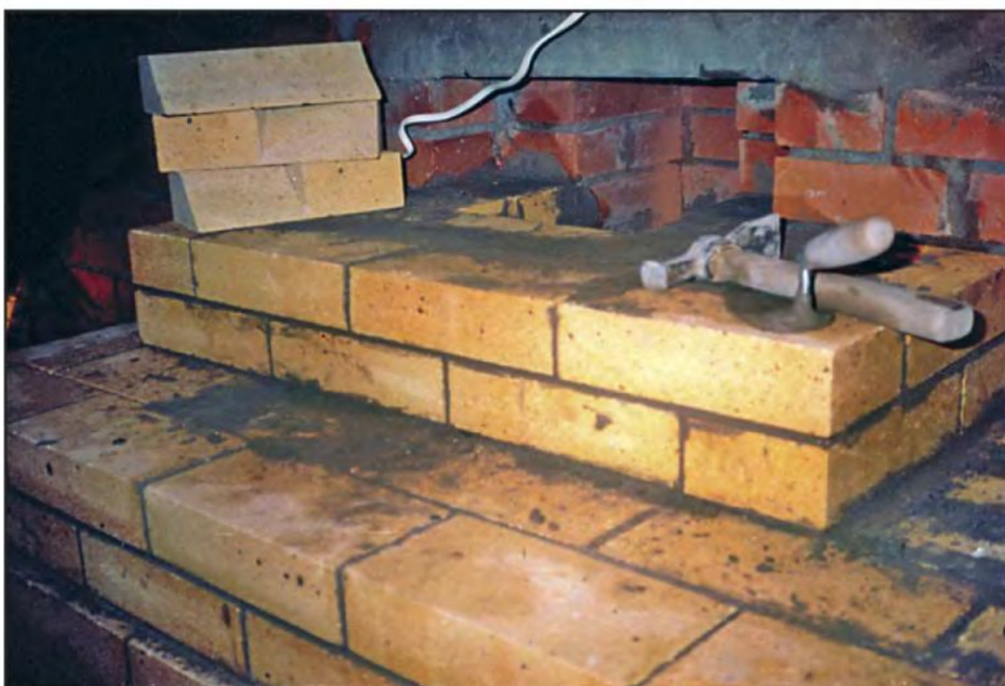
А это — присоединение объединённого дымохода к трубе и завершающие верхние ряды.
