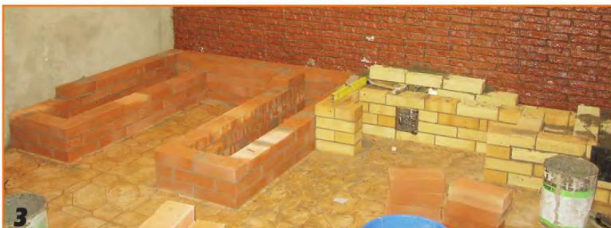
Так выглядит кухонный печной комплекс, состоящий из трёх очагов.
