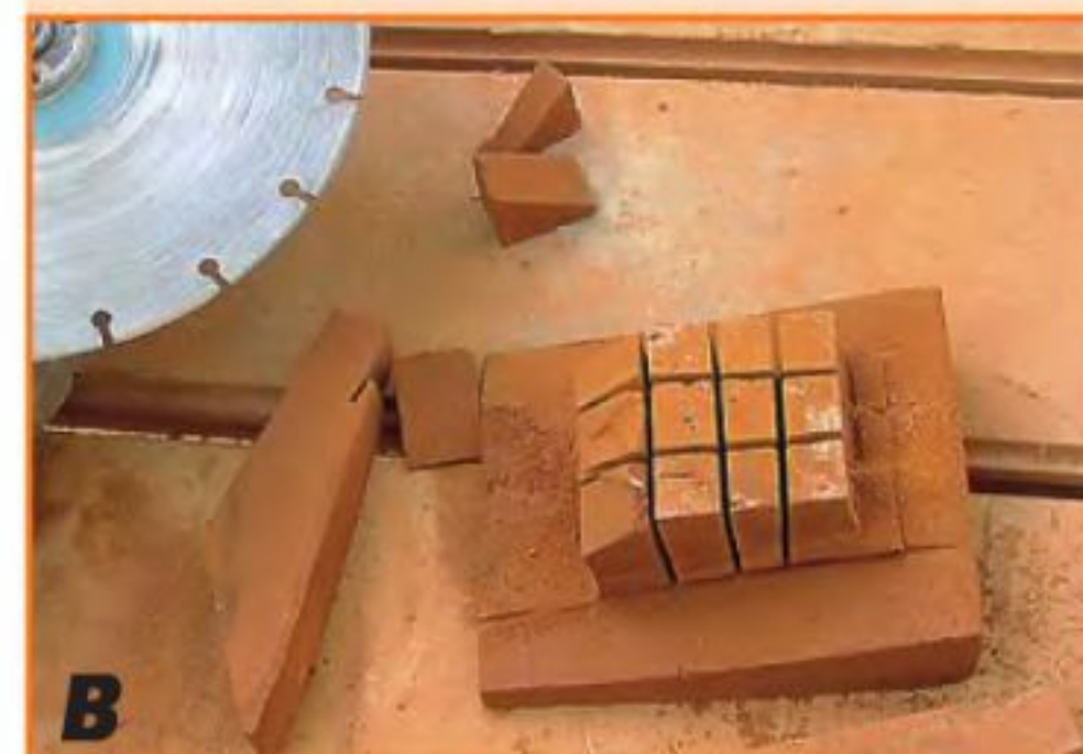
Отрезной машинкой с алмазным кругом сделали надрезы на кирпиче до нанесённых контуров.
