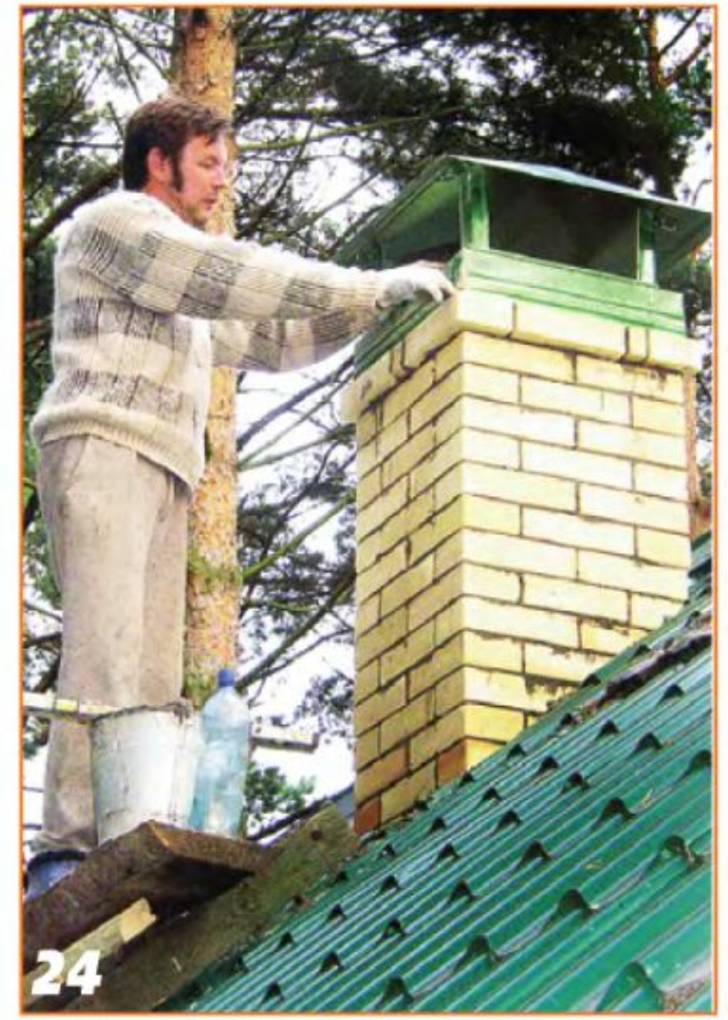
Установка зонтика на трубу русской печи.
