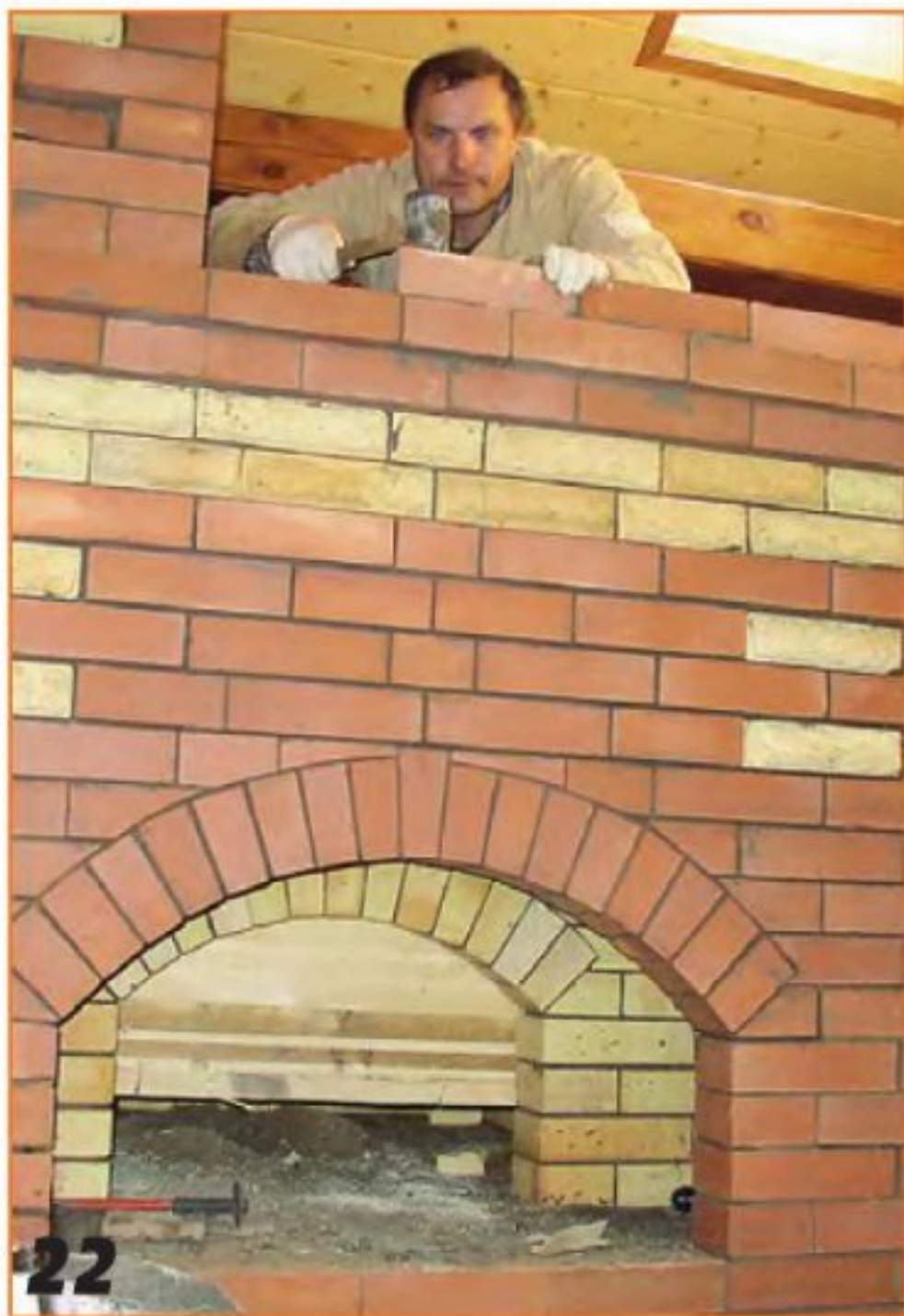
Последние ряды кладки. Вставки из шамотного кирпича дают понять, что русская печь является составной частью этого отопительно-варочного комплекса.
