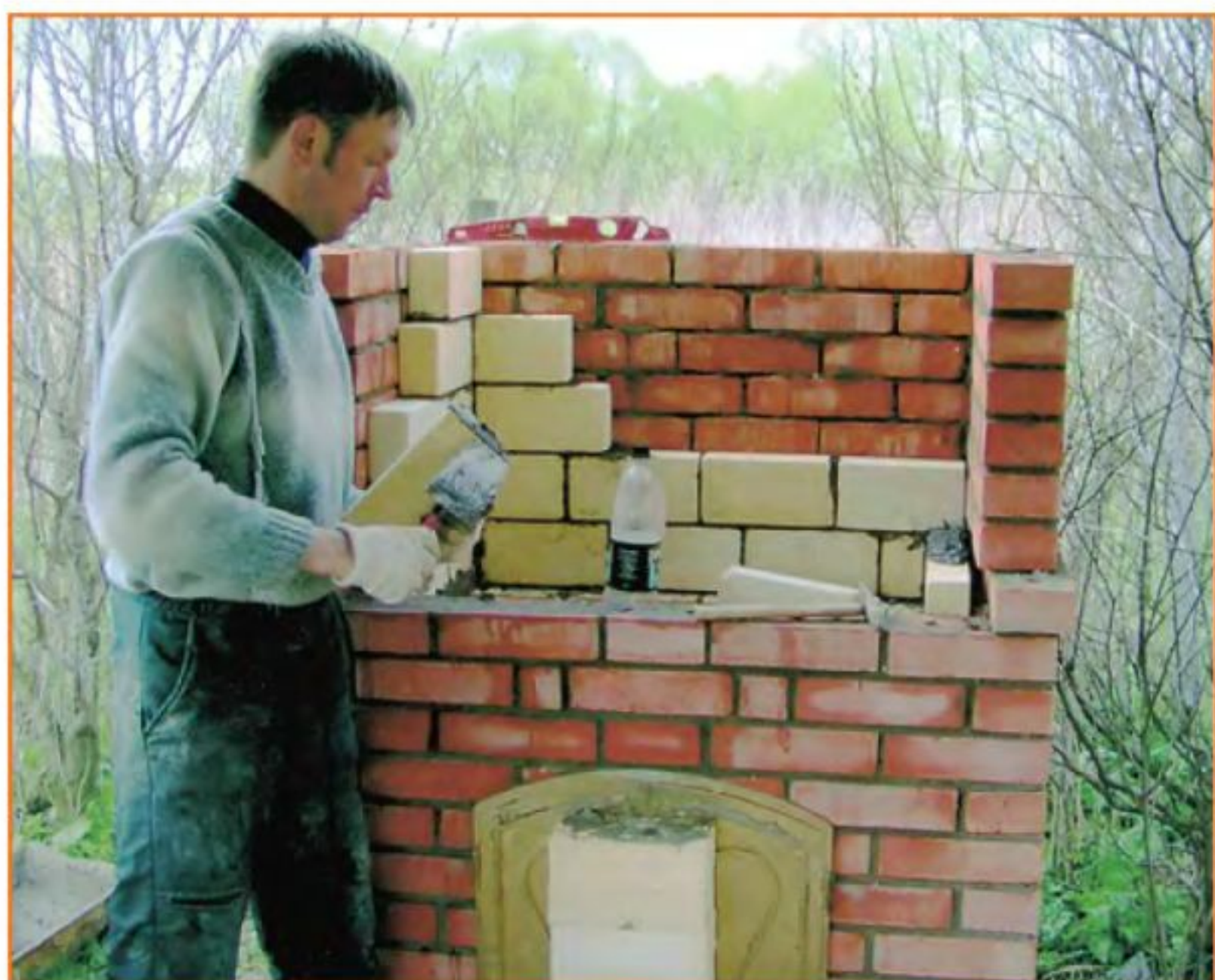
Для футеровки топливника брали шамотный кирпич и глиняно-песчаный раствор.
