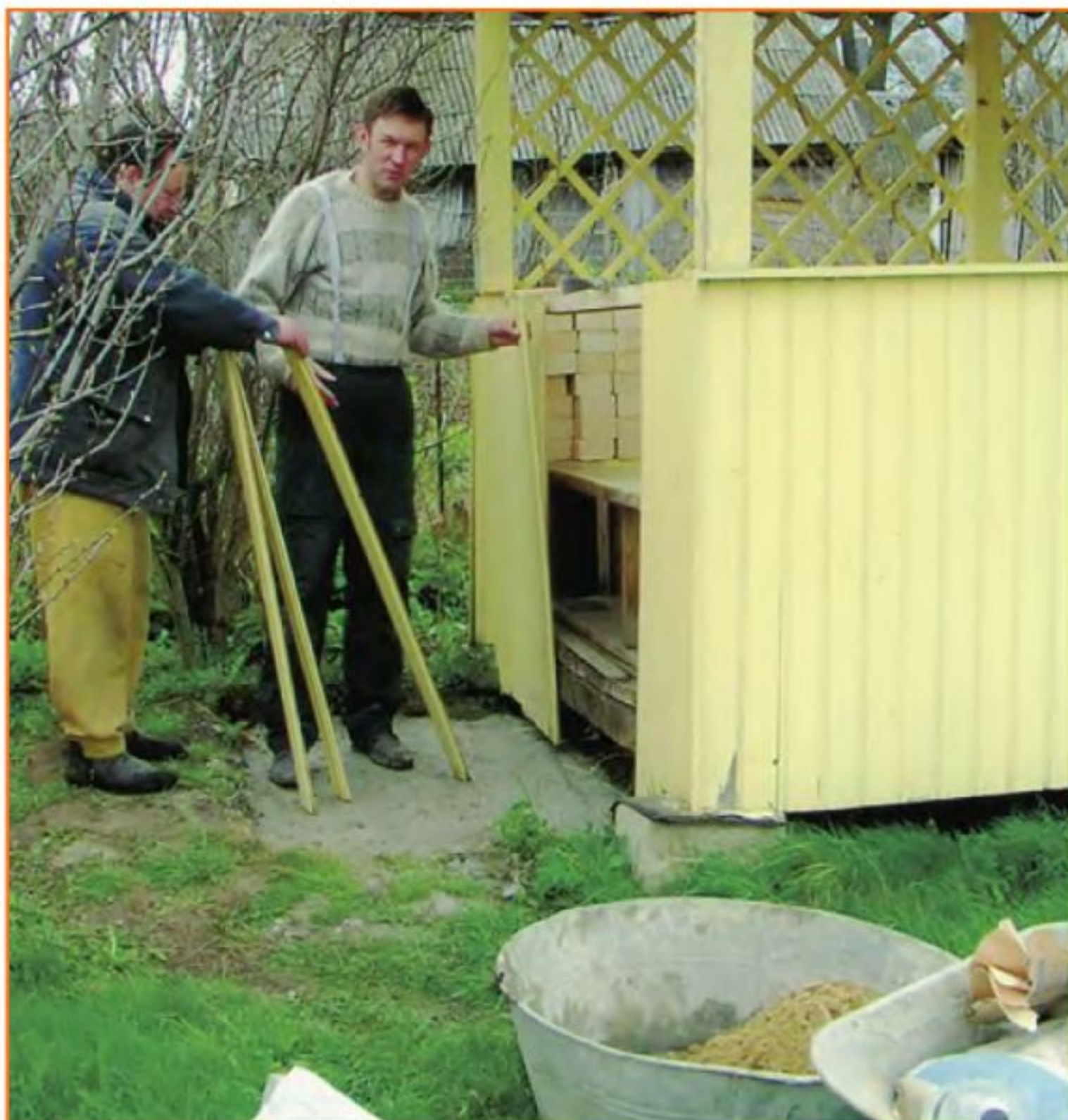
Противоположную от входа стену беседки (обшивку) демонтировали.
